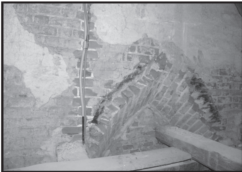
Fot. 3. Zachowane okno gotyckie na ścianie północnej, w poziomie poddasza prezbiterium. H. Landecka, 2008.
