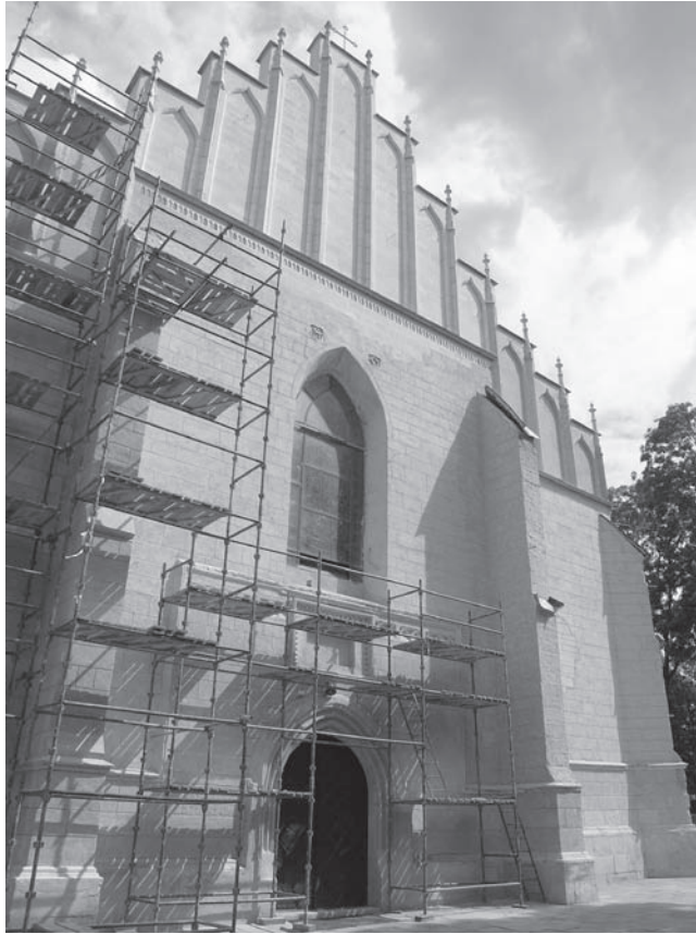
Fot. 6. Fasada zachodnia kościoła w trakcie prac konserwatorskich po odtworzeniu szczytu gotyckiego. H. Landecka, 2010.
