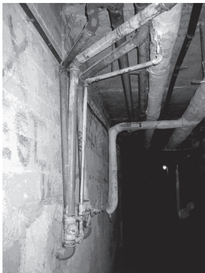
Rys. 9. Budynek prefabrykowany piwnice, stan instalacji c.w.u. i c.o.
