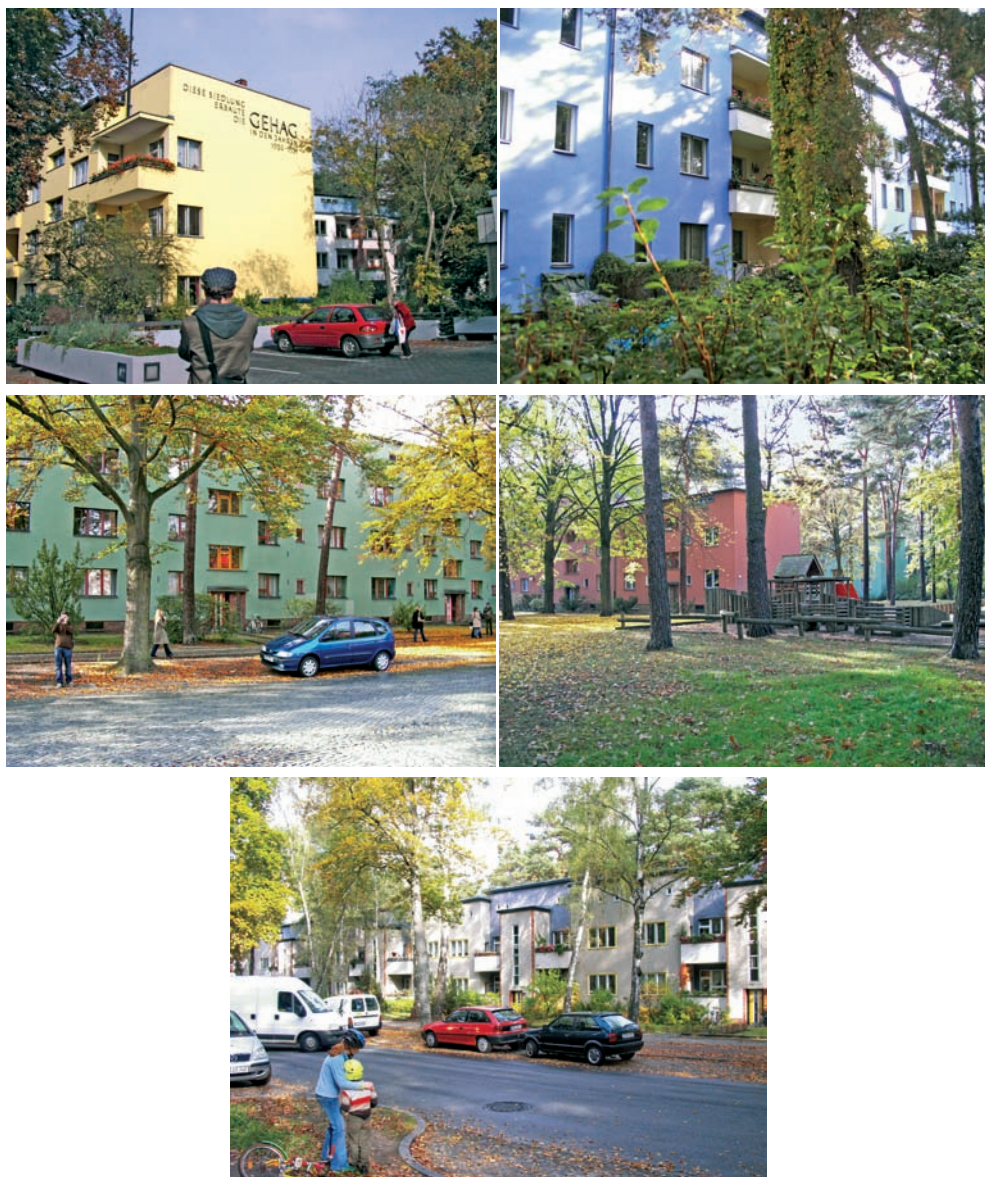
Rys. 23, 24, 25, 26, 27. Fragmenty przestrzeni osiedla różnie ukształtowane za pomocą relacji lasu z zabudową (leśne drzewa obecne są w przestrzeni szerokich ulic, oraz pomiędzy domami) , której architekturze wyraz nadaje różne ukształtowanie elewacji (jedno i wielopłaszczyznowe, z użyciem jedynie tynku bądź z wstawkami z innych materiałów, zastosowanie bądź nie zaokrąglenia), a także różnorodna kolorystyka. Zdjęcie: Hubert Trammer – 21 X 2006.
