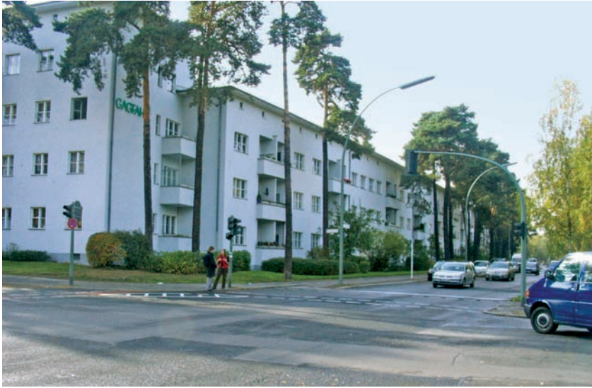
Rys. 4 Zabudowa mieszkaniowa wypełniająca północno-wschodni narożnik kwartału w którym znajduje się stacja metra wraz z towarzyszącym jej zespołem handlowo-usługowym. Widoczny charakterystyczny dla zamkniętych kwartałów na terenie osiedla wklęsły narożnik. Zdjęcie: Hubert Trammer – 21 X 2006.
