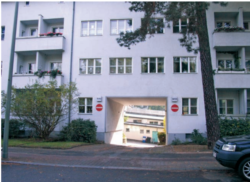
Rys. 5. Brama umożliwiająca pojazdom zaopatrzenia północnego pasażu handlowego wyjazd z kwartału. Zdjęcie: Hubert Trammer – 21 X 2006.
