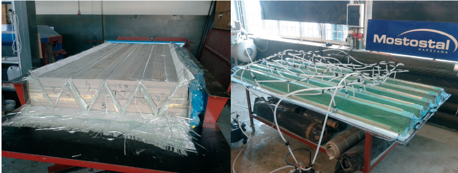
Rys. 2. Zastosowanie technologii infuzji próżniowej do wykonania paneli kompozytowych. Po lewej układanie tkanin zbrojących panelu II w formie, po prawej część panelu III podczas infuzji żywicą
