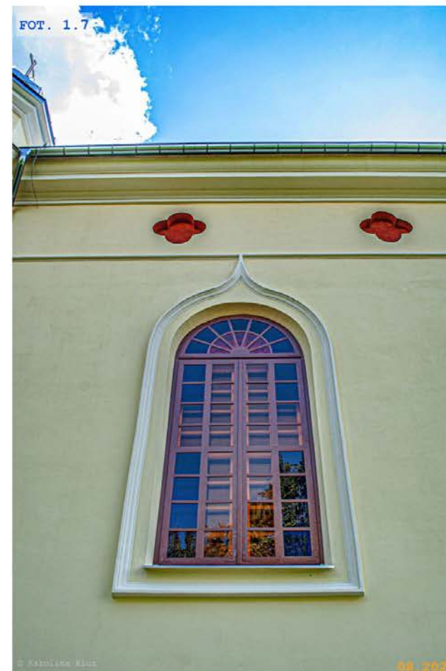
FOT. 1.7 Okno zamknięte półkoliście, w profilowanym obramieniu zamkniętym w ośli grzbiet
