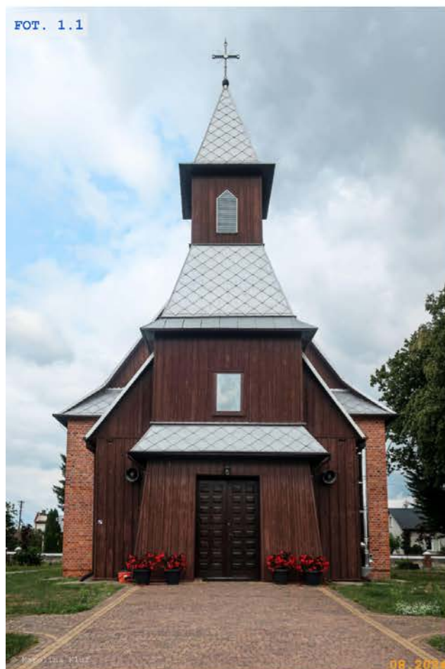
FOT. 1.1 Elewacja południowa
