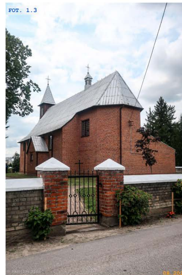
FOT. 1.3 Widok północno-wschodni
