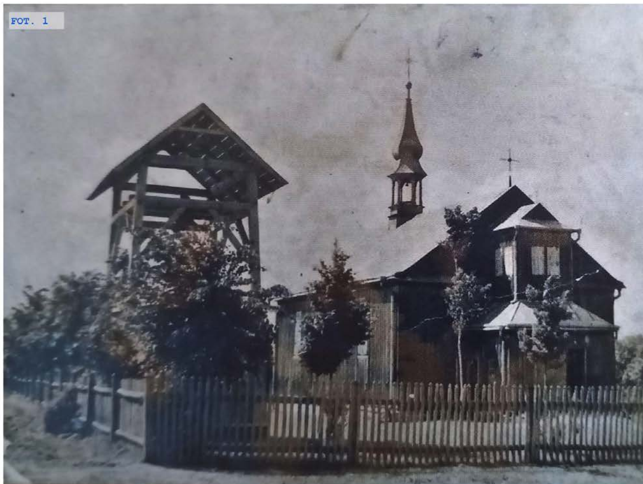
FOT. 1 Widok południowo-wschodni
