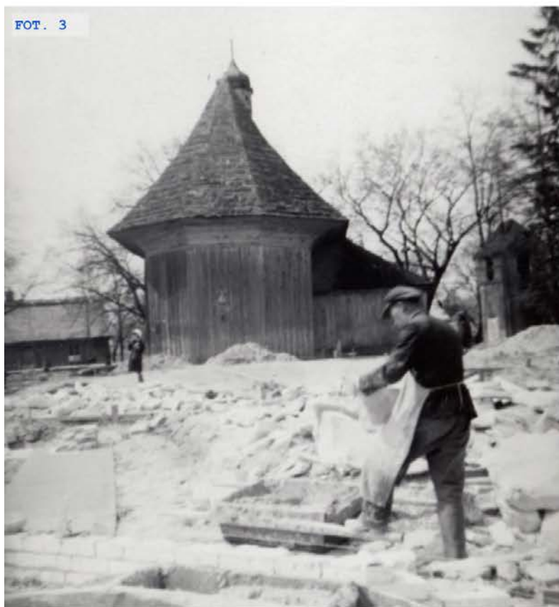
FOT. 3 Budowa fundamentów nowego kościoła w Kaniem, w tle stary kościół i po prawej dzwonnica (fot. z archiwum G. Wojciechowskiego)
