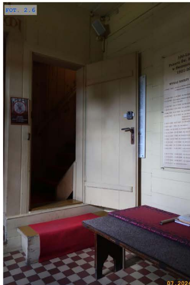
FOT. 2.6 Klatka schodowa na chór
