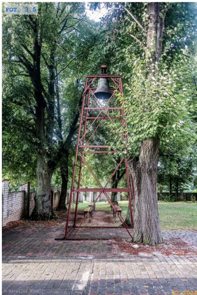
FOT. 3.5 Dzwonnica r.
