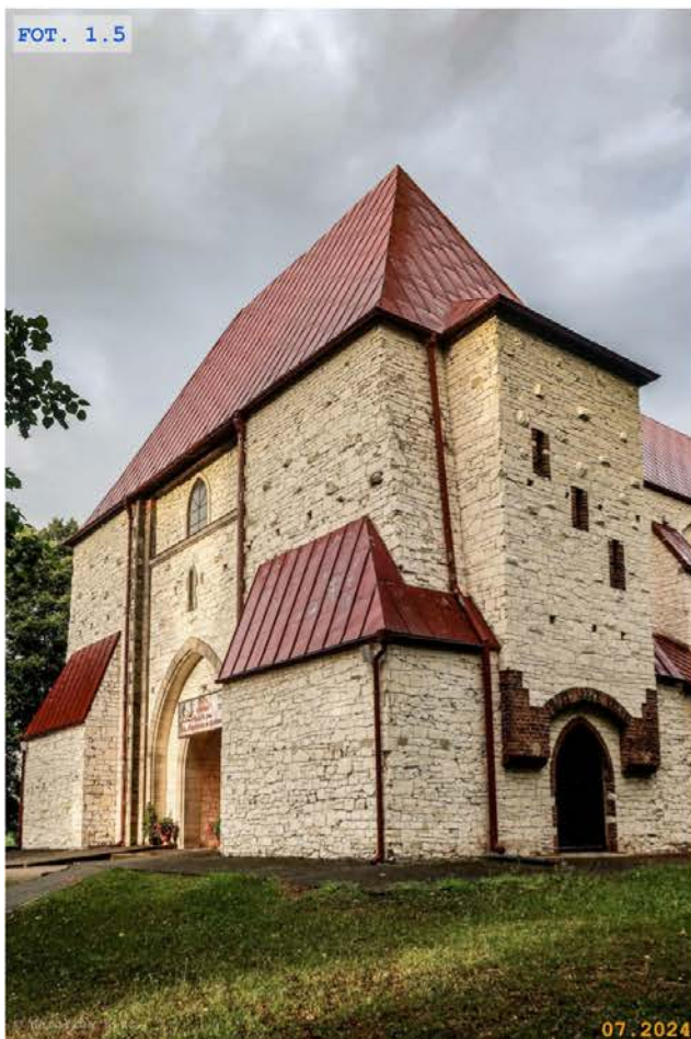
FOT. 1.5 Widok południowo-zachodni. Fasada i wykusz elewacji południowej
