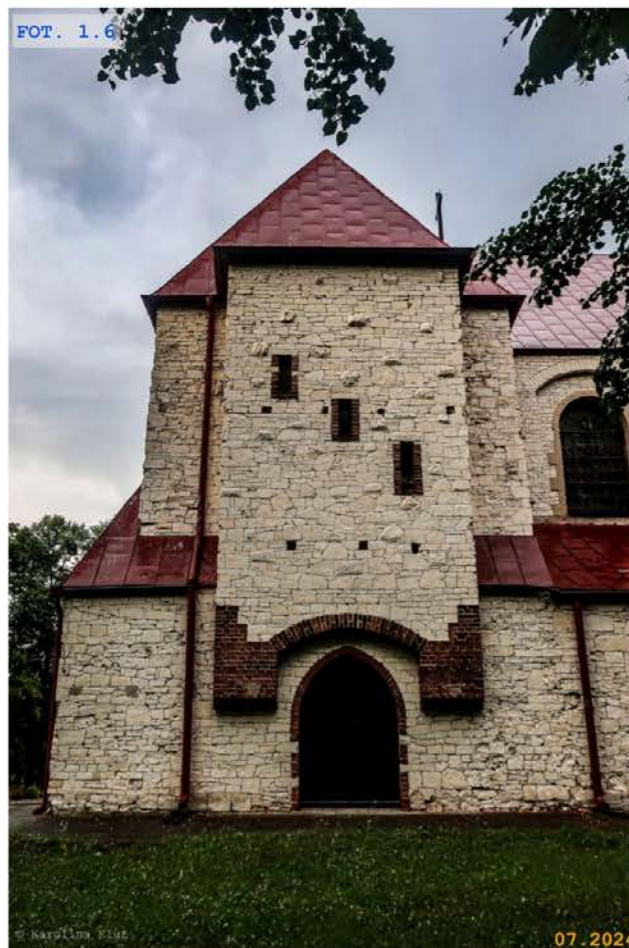
FOT. 1.6 Wykusz elewacji południowej. Wejście południowe
