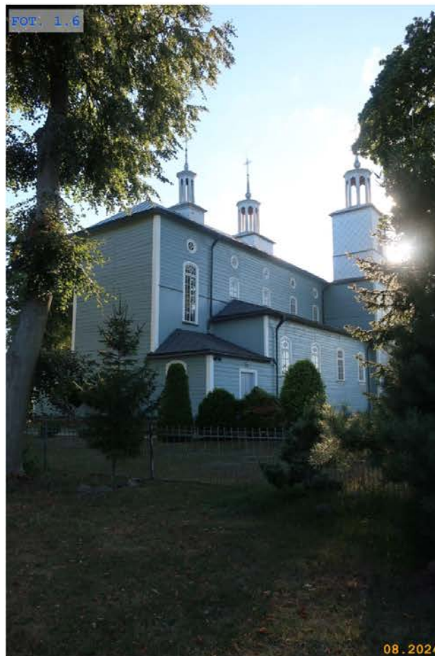
FOT. 1.6 Widok południowo-wschodni
