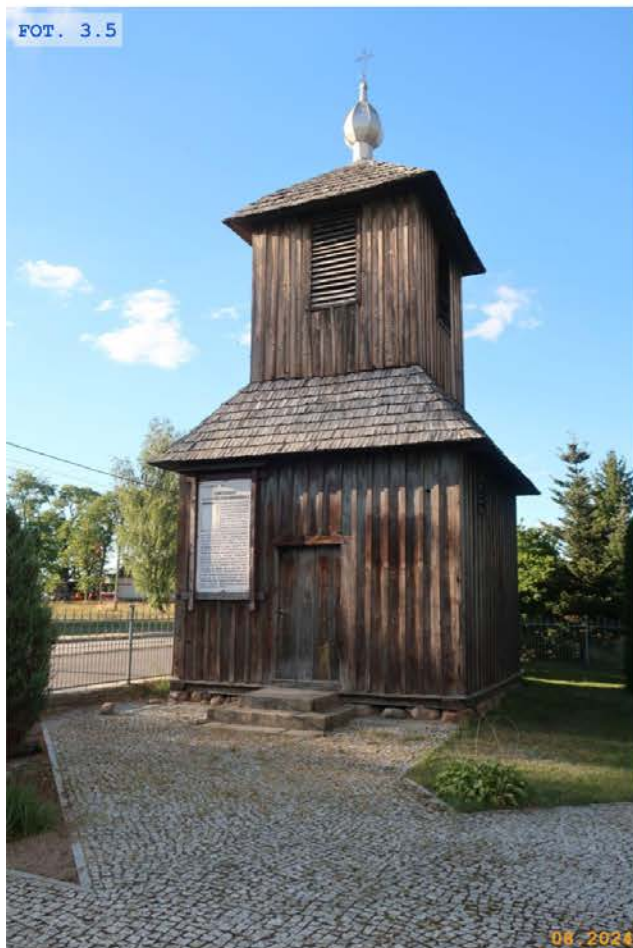
FOT. 3.5 Dzwonnica 1830 r.
