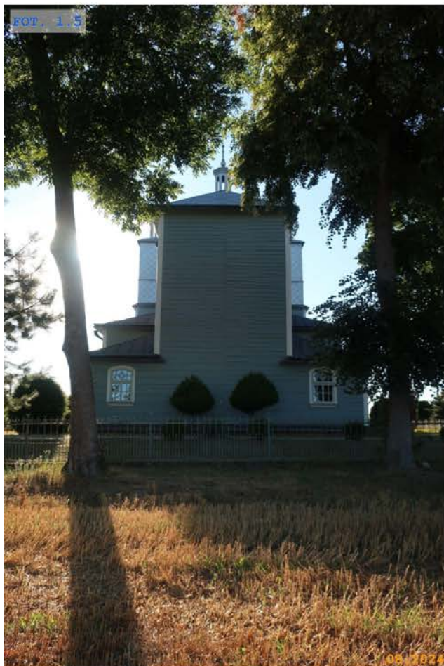
FOT. 1.5 Elewacja wschodnia
