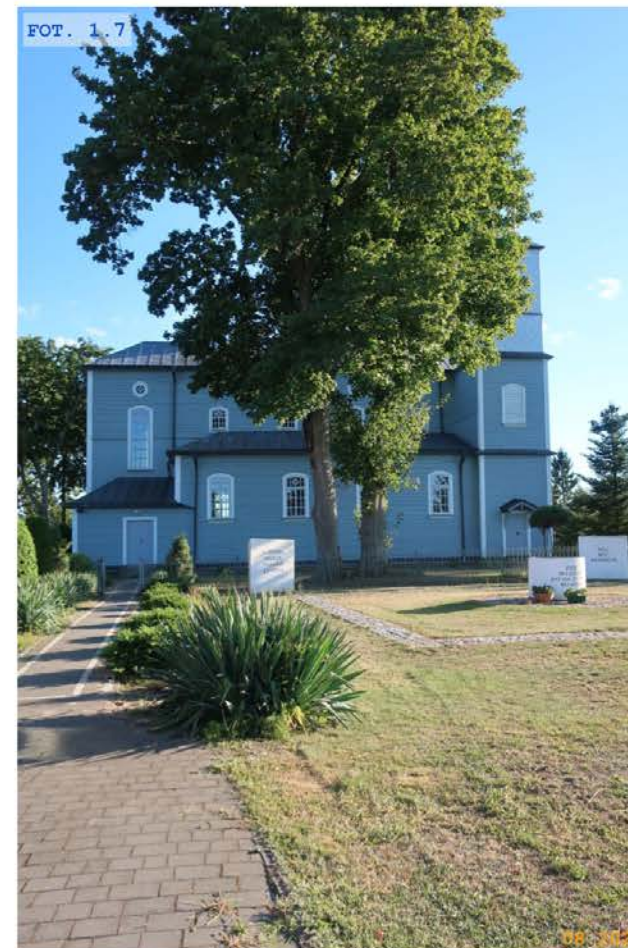
FOT. 1.7 Elewacja południowa
