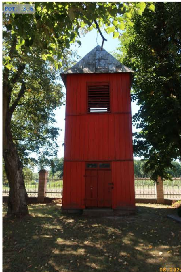
FOT. 3.6 Dzwonnica 1938 r.
