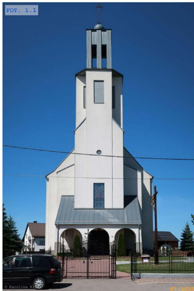
FOT. 1.1 Elewacja południowo-zachodnia
