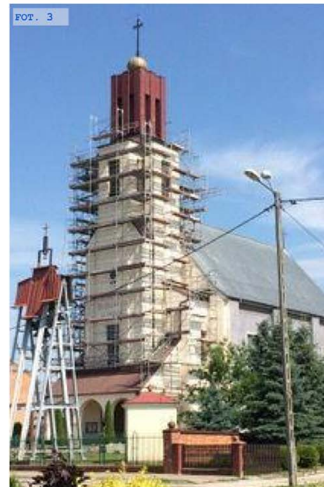
FOT. 3 Widok południowy. Remont 2016
