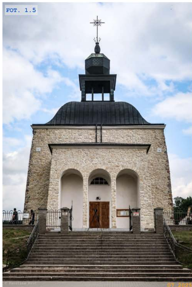
FOT. 1.5 Elewacja południowa
