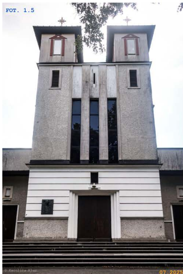
FOT. 1.5 Elewacja północno-wschodnia
