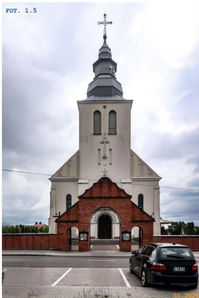
FOT. 1.5 Elewacja zachodnia
