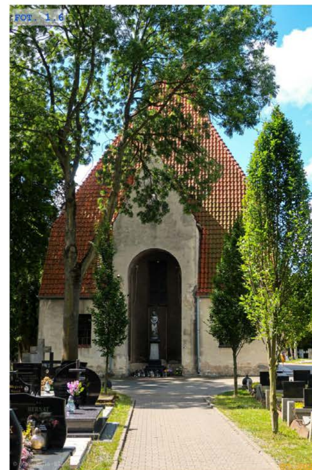
FOT. 1.6 Elewacja północna
