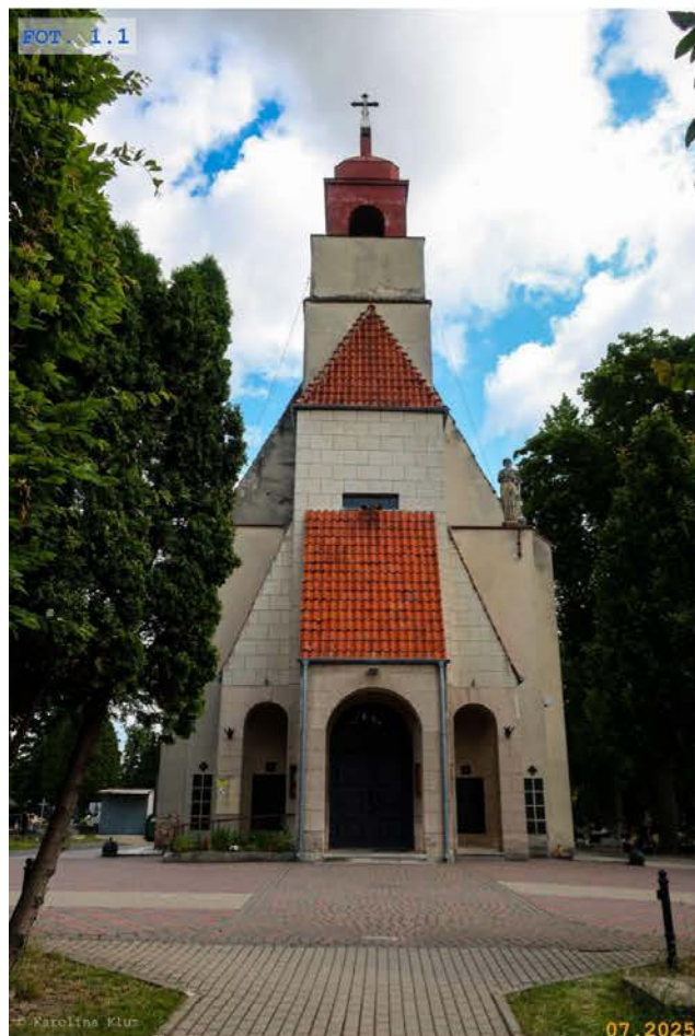
FOT. 1.1 Elewacja południowa
