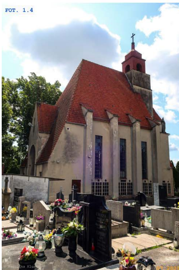
FOT. 1.4 Elewacja zachodnia
