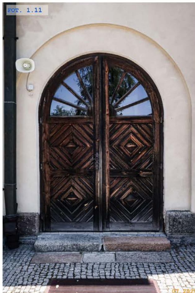
FOT. 1.11 Drzwi boczne (wschodnie) w fasadzie
