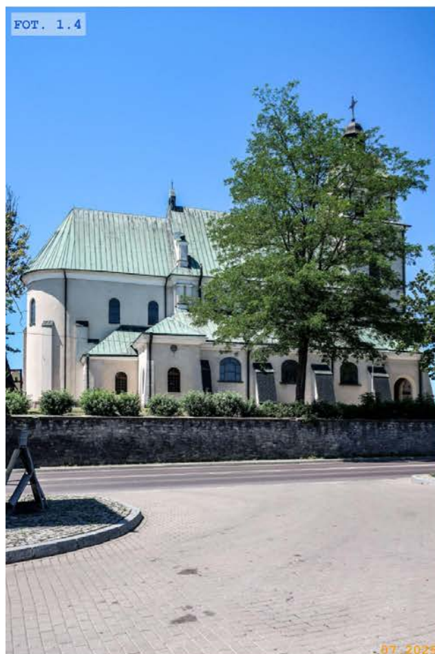
FOT. 1.4 Elewacja wschodnia
