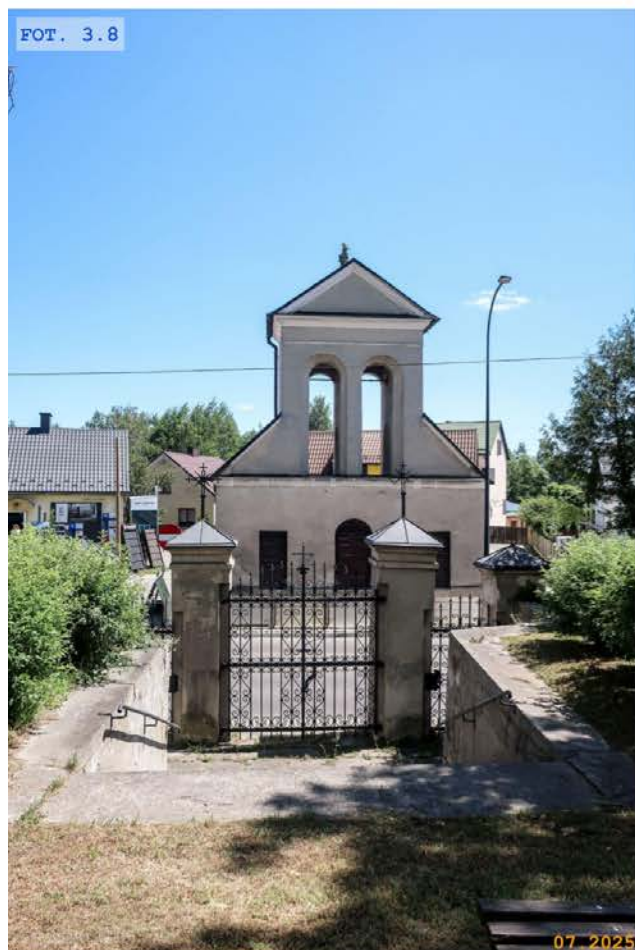
FOT. 3.8 Brama wschodnia. Widok w kierunku dzwonnicy
