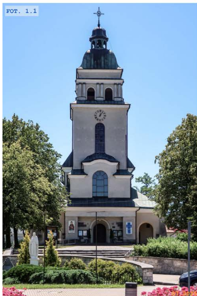
FOT. 1.1 Elewacja północna
