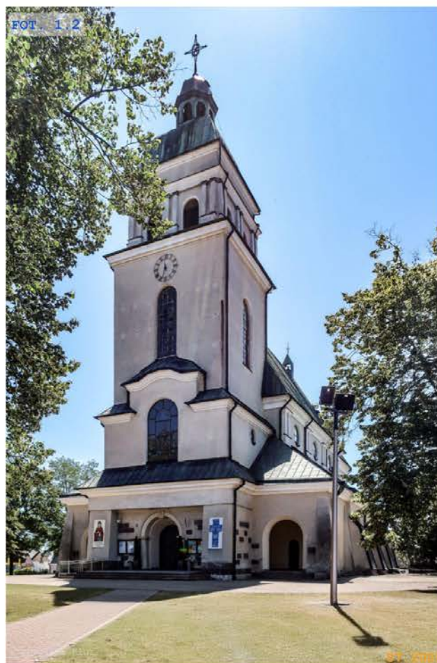
FOT. 1.2 Widok północno-zachodni
