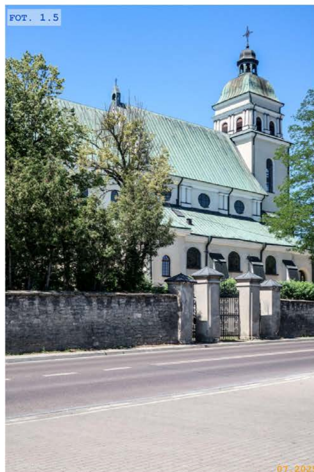
FOT. 1.5 Widok południowo-wschodni
