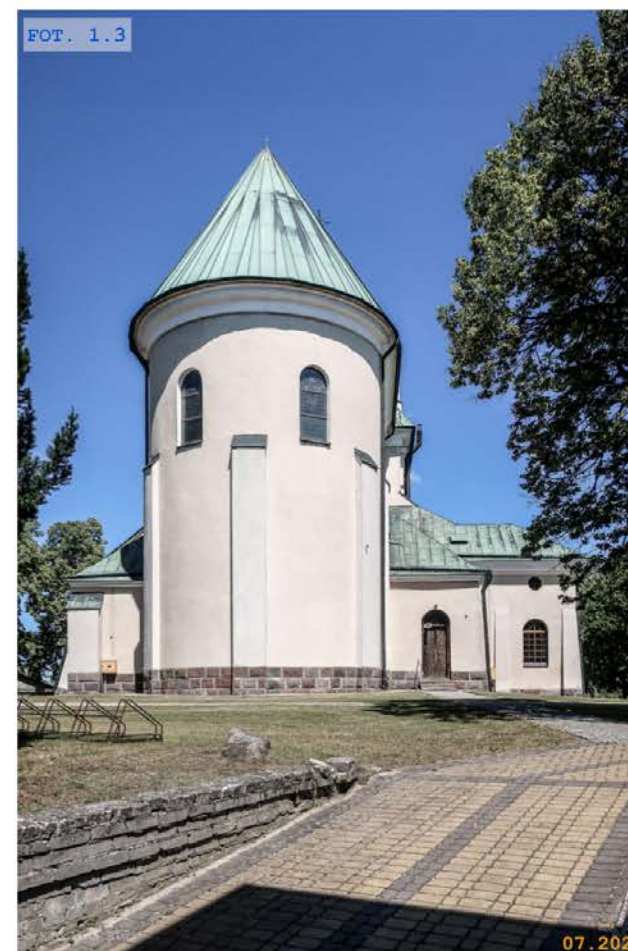
FOT. 1.3 Elewacja południowa
