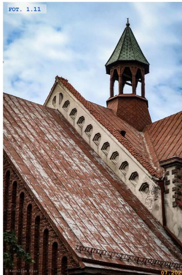
FOT. 1.11 Szczyty nawy i zakrystii
