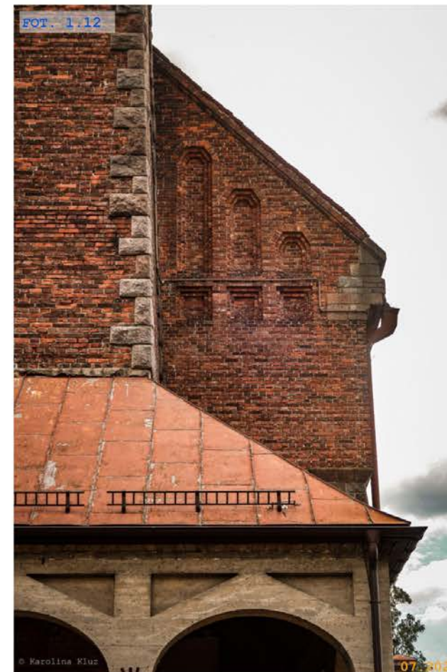
FOT. 1.12 Detal podcienia i półszczytowej ściany nawy
