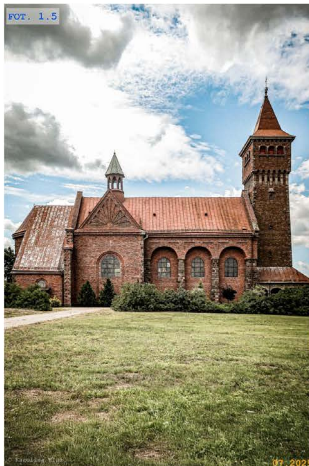
FOT. 1.5 Elewacja północna
