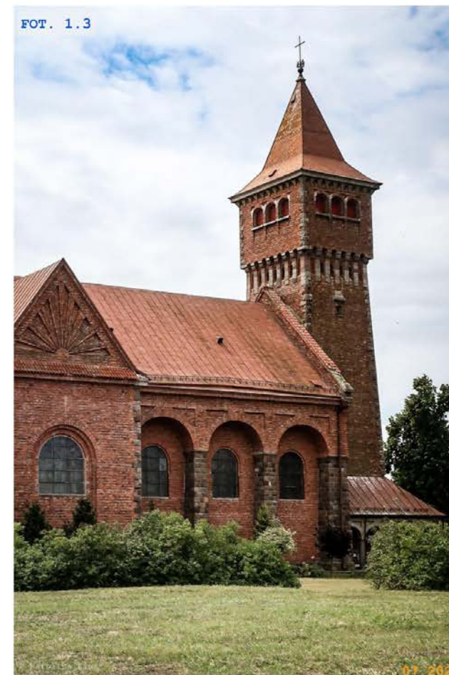
FOT. 1.3 Widok północno-wschodni
