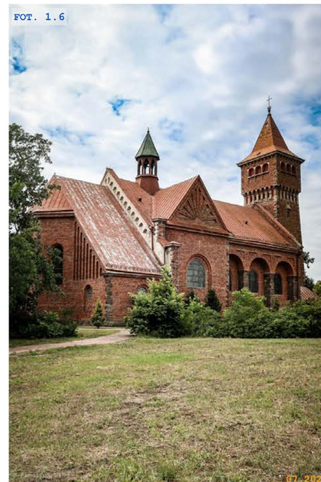
FOT. 1.6 Widok północno-wschodni
