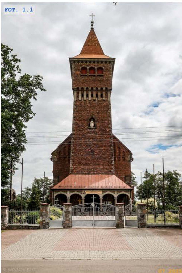
FOT. 1.1 Elewacja zachodnia
