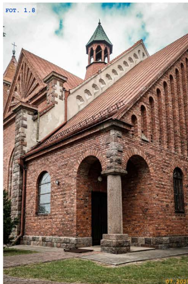
FOT. 1.8 Podcieniowe wejście do zakrystii
