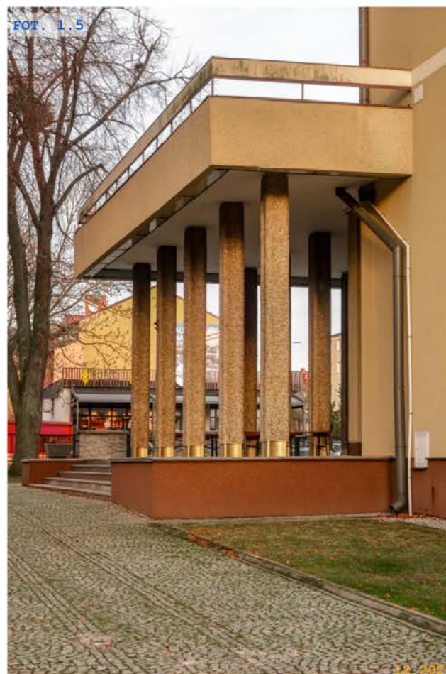
FOT. 1.5 Portyk. Widok południowo-zachodni
