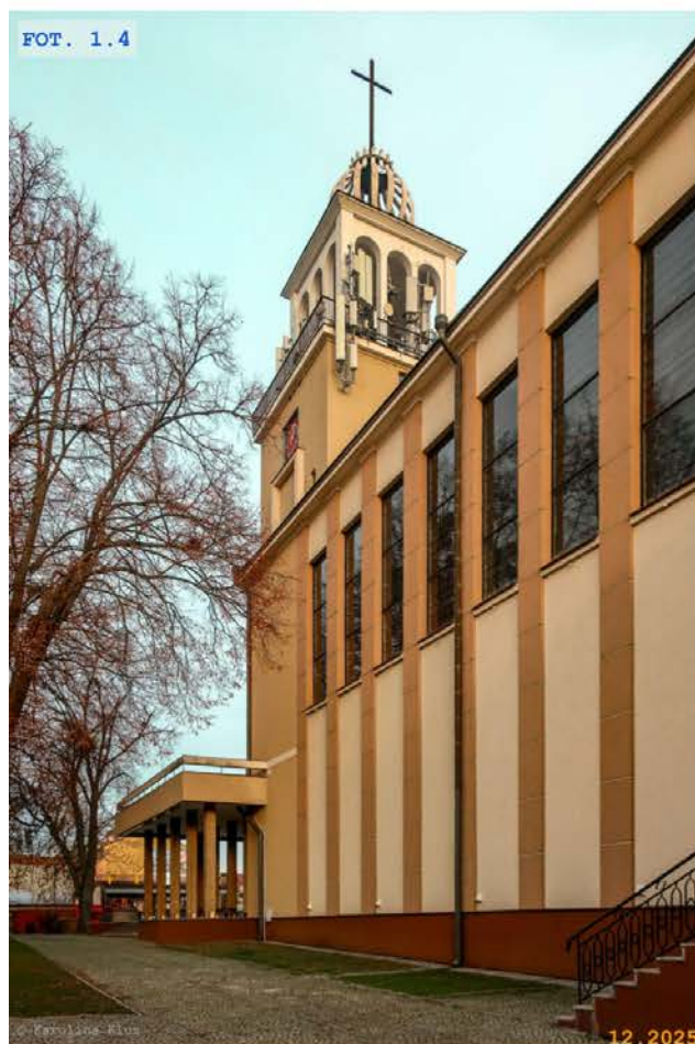
FOT. 1.4 Widok południowo-zachodni
