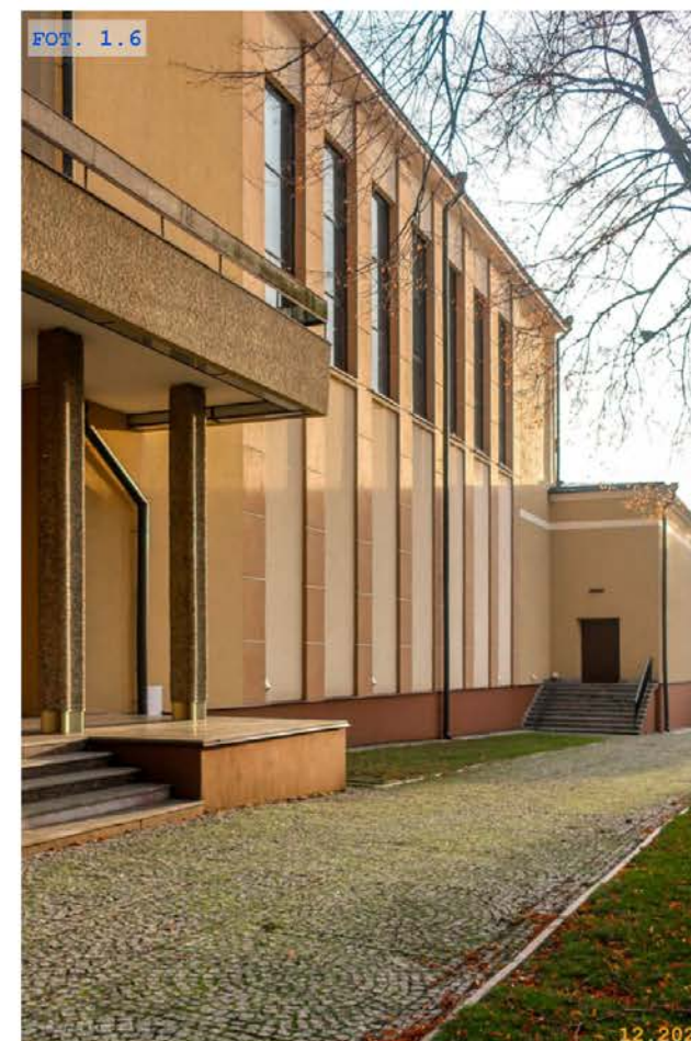
FOT. 1.6 Widok północno-zachodni
