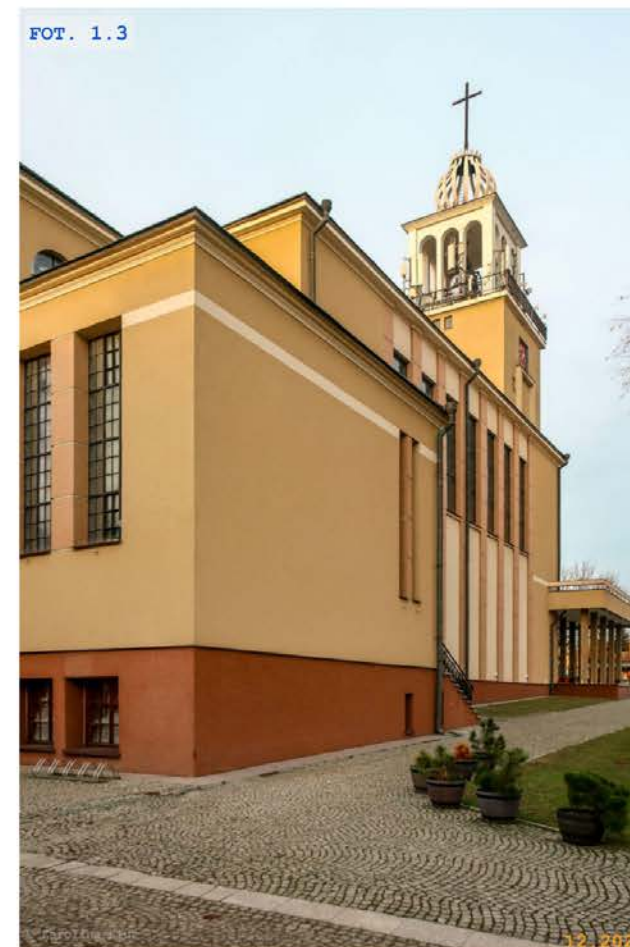
FOT. 1.3 Widok południowo-wschodni
