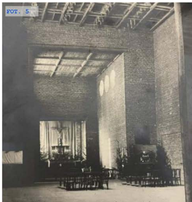
FOT. 5 Wnętrze kościoła. Widok w kierunku prezbiterium, 1946 r.
