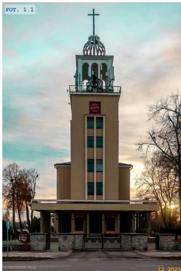
FOT. 1.1 Elewacja północna
