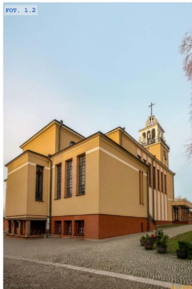
FOT. 1.2 Widok południowo-wschodni
