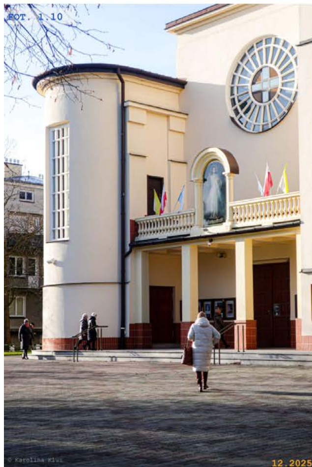
FOT. 1.10 Podcień z balkonem w fasadzie kościoła i aneks klatki schodowej
