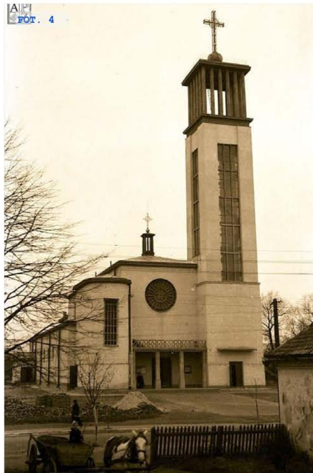
FOT. 4 Widok fasady kościoła 1958 r.
