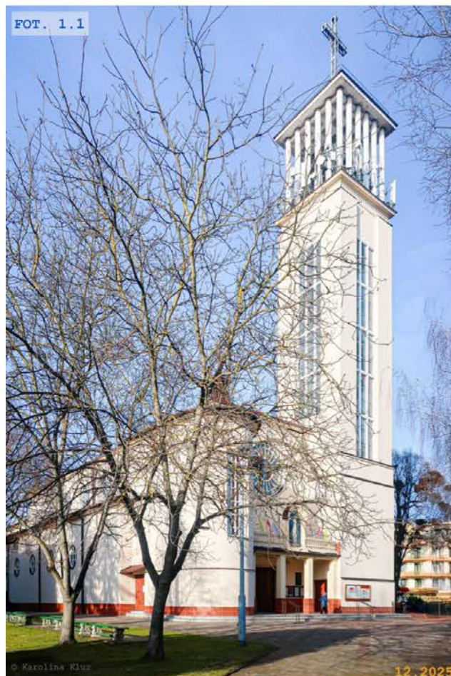
FOT. 1.1 Widok południowo-wschodni
