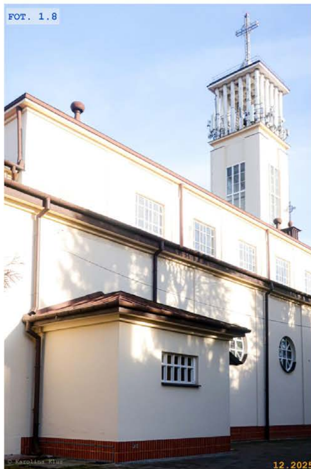
FOT. 1.8 Naroże południowo-zachodnie
