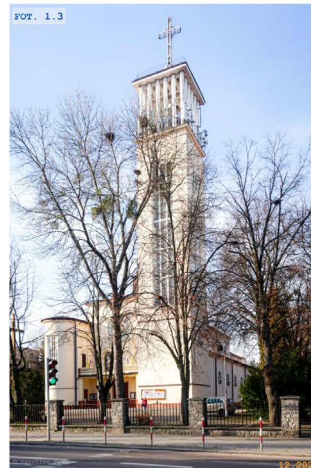
FOT. 1.3 Widok północno-wschodni
