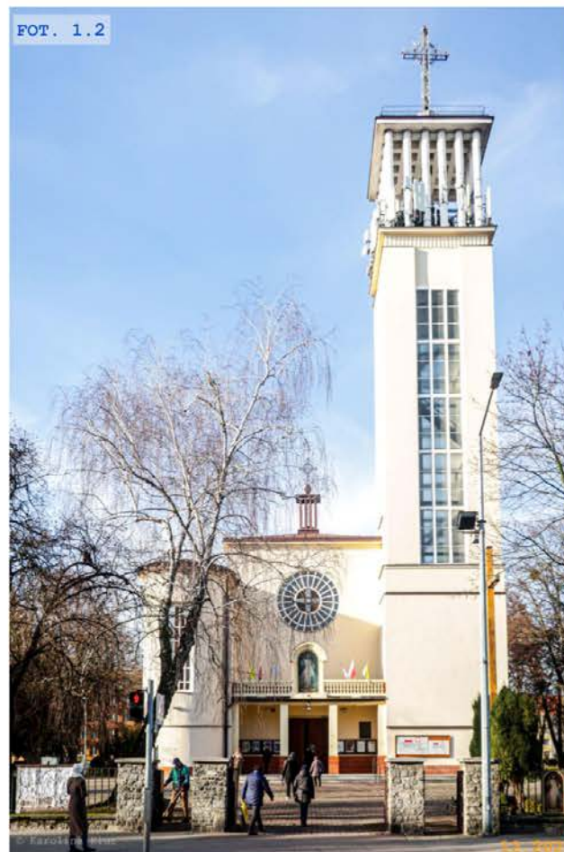
FOT. 1.2 Elewacja wschodnia
