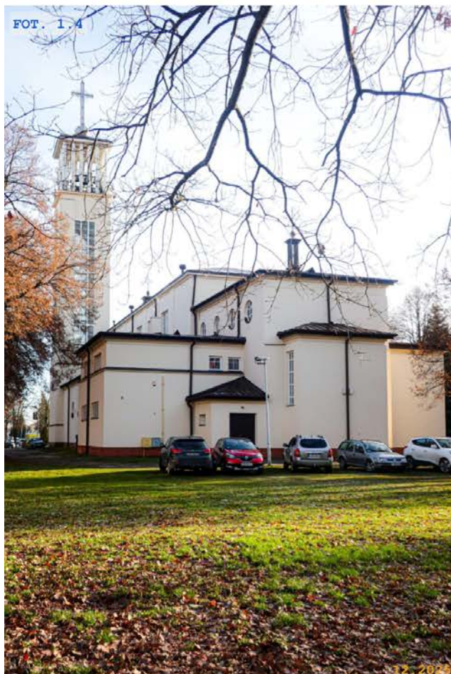
FOT. 1.4 Widok północno-zachodni
