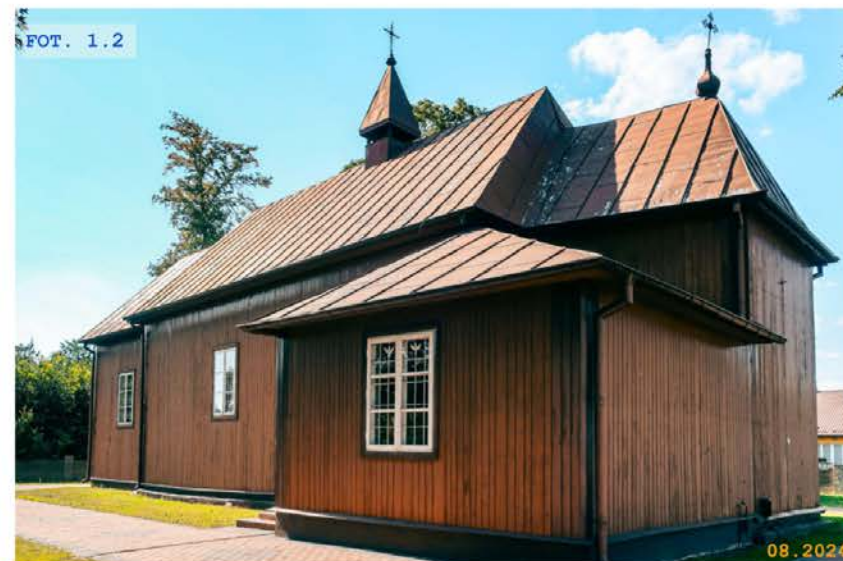
FOT. 1.1 Fasada zachodnia
