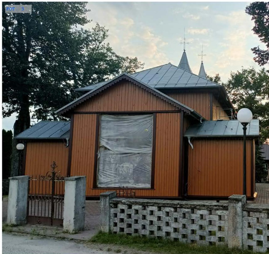
FOT. 3 Elewacja wschodnia kościoła w Hrudzie w trakcie prac remontowych (2023 r.)
