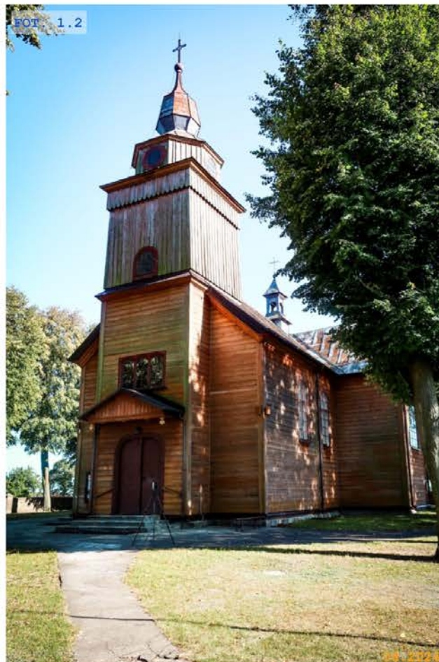
FOT. 1.2 Widok północno-zachodni
