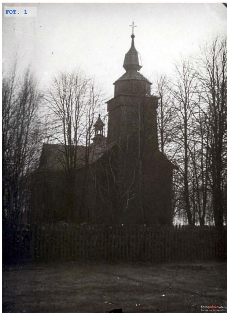
FOT. 1 Widok północno-wschodni
