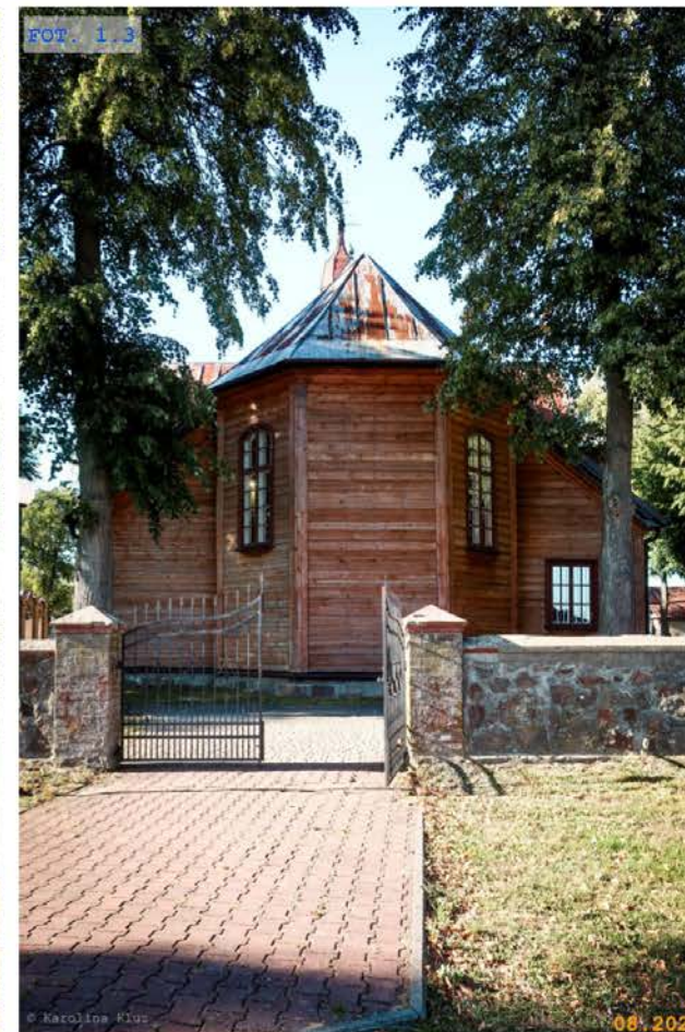
FOT. 1.3 Elewacja południowa
