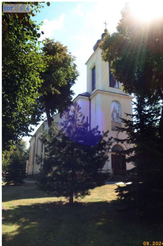
FOT. 1.6 Widok północno-wschodni
