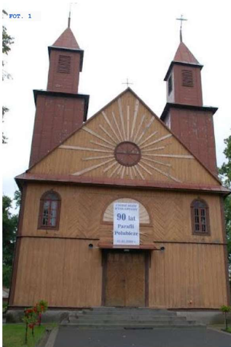
FOT. 1 Elewacja frontowa (zachodnia)
