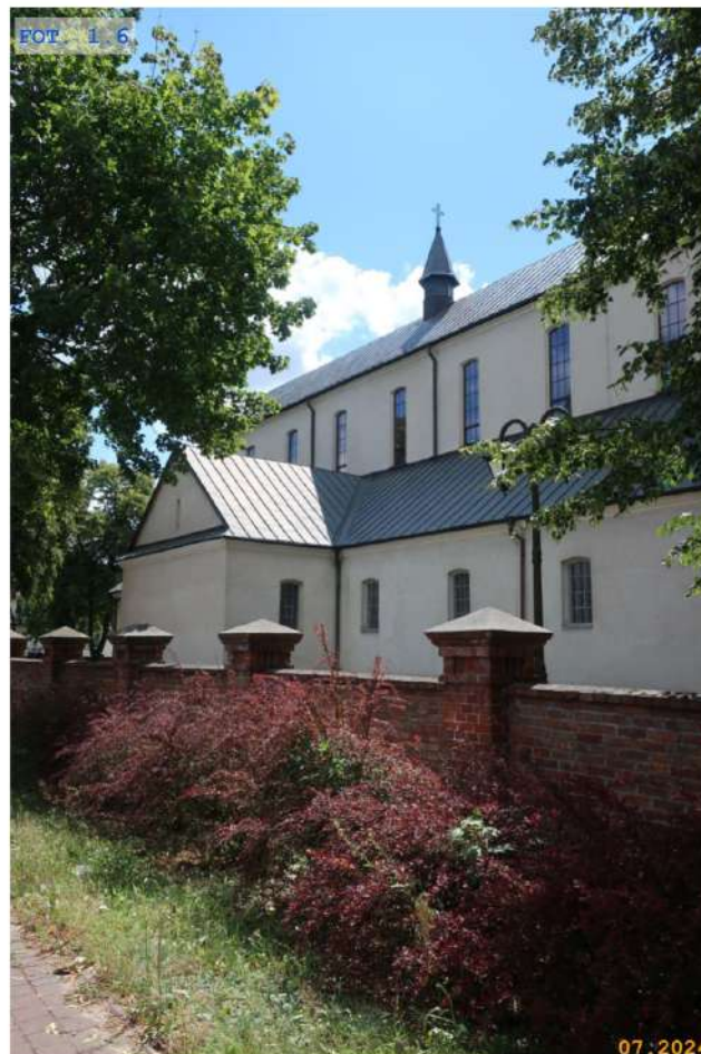
FOT. 1.6 Elewacja wschodnia. Widok pn.-wsch.
