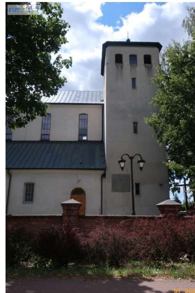
FOT. 1.7 Wieża wschodnia
