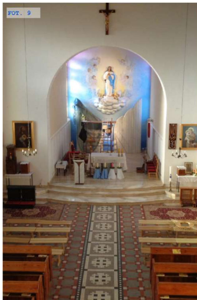
FOT. 9 Prezbiterium w trakcie prac modernizacyjnych lipiec-grudzień 2015 r.
