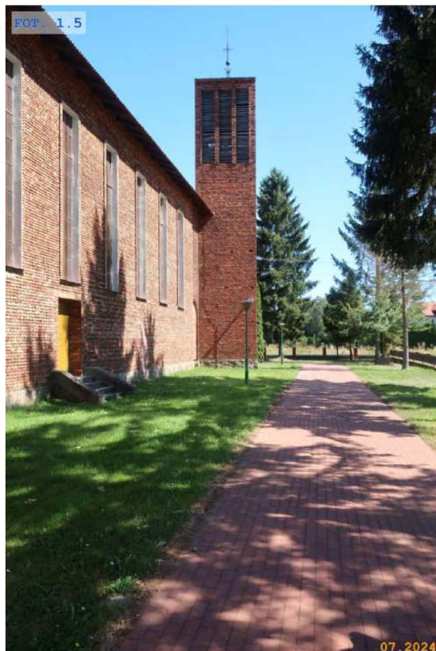
FOT. 1.5 Wieża kościoła w widoku zachodnim
