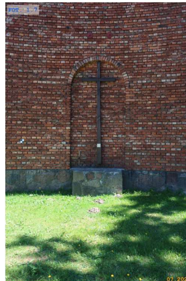
FOT. 1.7 Nisza w ścianie prezbiterium
