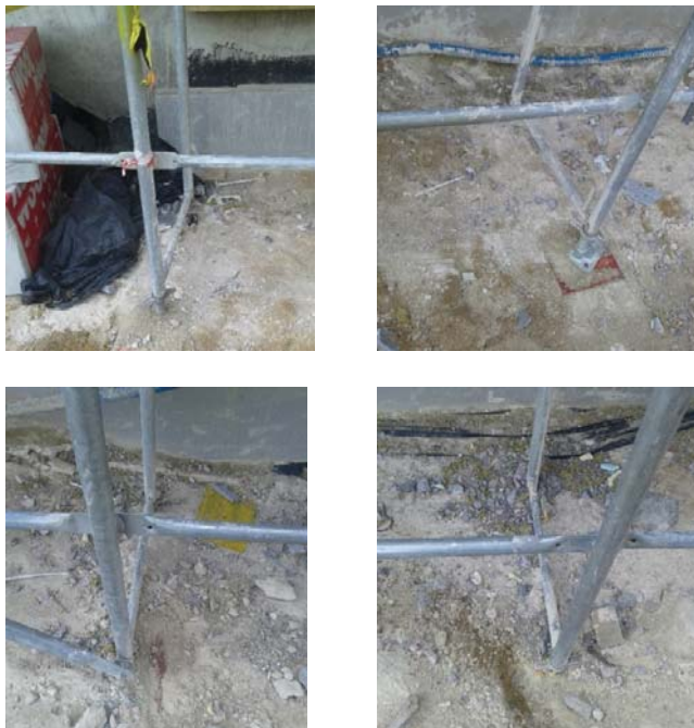
Rys. 3-20. Posadowienie rusztowania L12 na budowie [zdjęcia – projekt ORKWIZ]
