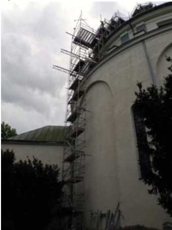
Rys. 5-38. Rusztowanie przy kościele w Hodyszewie: a) rusztowanie wokół wieży, b) pion komunikacyjny, c) część rusztowania, stanowiąca wzmocnienie kotwienia konstrukcji [zdjęcia własne]
