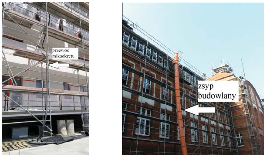
Rys. 6-34. Przewód miksokretu na rusztowaniu L04 oraz zsypanie budowlane na rusztowaniu P13 [zdjęcia – projekt ORKWIZ]
