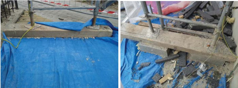
Rys. 6-1. Rusztowanie P06: a) widok rusztowania, b) przykłady ustawienia rusztowania na podkładach [zdjęcia – projekt ORKWIZ]
