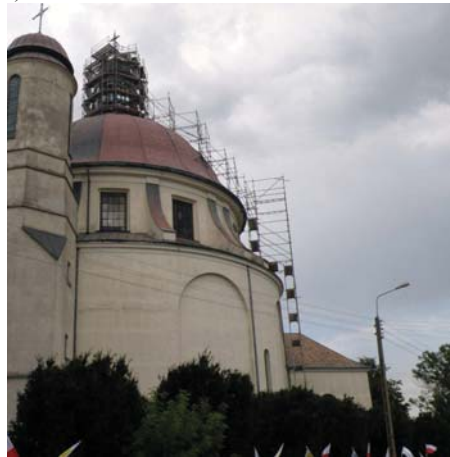
Rys. 5-38. Rusztowanie przy kościele w Hodyszewie: a) rusztowanie wokół wieży, b) pion komunikacyjny, c) część rusztowania, stanowiąca wzmocnienie kotwienia konstrukcji [zdjęcia własne]
