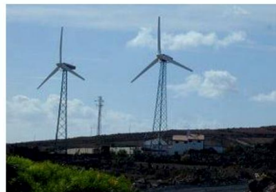
Przykłady wież elektrowni wiatrowych o konstrukcji kratownicowej
