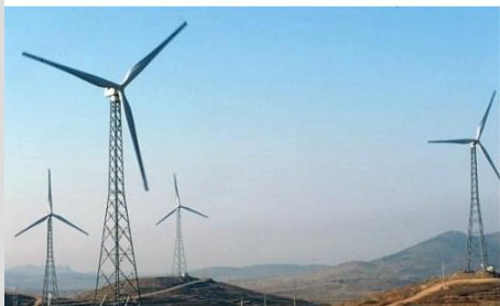
Przykłady wież elektrowni wiatrowych o konstrukcji kratownicowej
