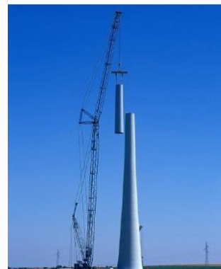
Etapy budowy wieży elektrowni o konstrukcji betonowej
