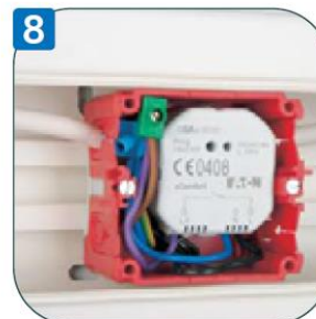
8 Montaż odbiornika w korytku kablowym
