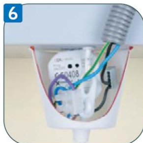
6 Montaż odbiornika za oprawą oświetleniową
