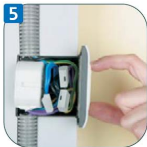
5 Montaż odbiornika za przyciskiem bezprzewodowym - rozwiązanie kombinowane
