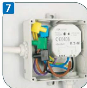
7 Montaż odbiornika w puszcze natynkowej
